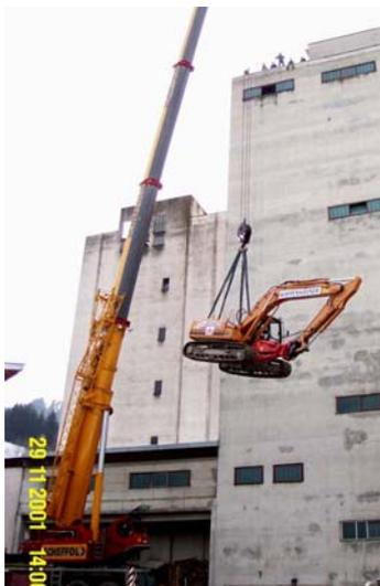
Am 29.11. wurde ein 22-to-Bagger von einem Kran auf das Plateau des großen Silos gehoben. Von dort arbeitet sich der Bagger mittels Abbruchzange und Schremmhammer nach unten. Der Betonabbruch wird der Wiederverwertung zugeführt. Aus Sicherheitsgründen muss die Innstraße während der Abbrucharbeiten, voraussichtlich
