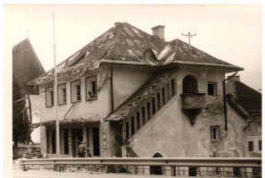
angehoben der Dachstuhl als Walmdach (passend zum Widum), durch die Fa. Holzbau Wegscheider aus Pill aufgestockt.
