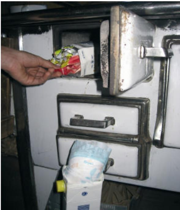
**Schnell anfeuern.** Für eine saubere Verbrennung sollte der Anfeuerungprozess möglichst schnell und ohne Rauchentwicklung erfolgen. Eine ausreichende Luftzufuhr ist dafür von zentraler Bedeutung. Das Stückholz möglichst locker in den Brennraum schichten, entgegen alter Gewohnheiten Holzspäne und umweltfreundliche Zündhilfe nicht unter, sondern auf das Holz legen und auf eine schnelle, hohe Flammenbildung achten. Kein Papier oder Karton benutzen, sie verursachen Schadstoffe!
